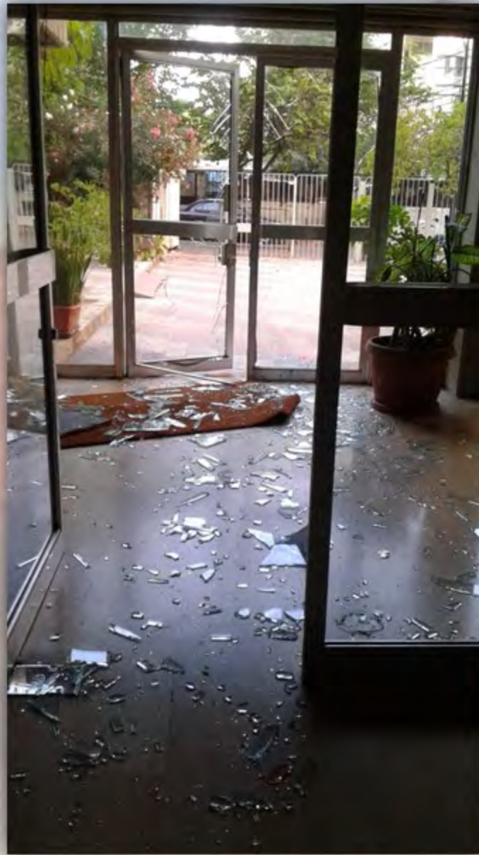
N.E.S.T. Main Entrance
